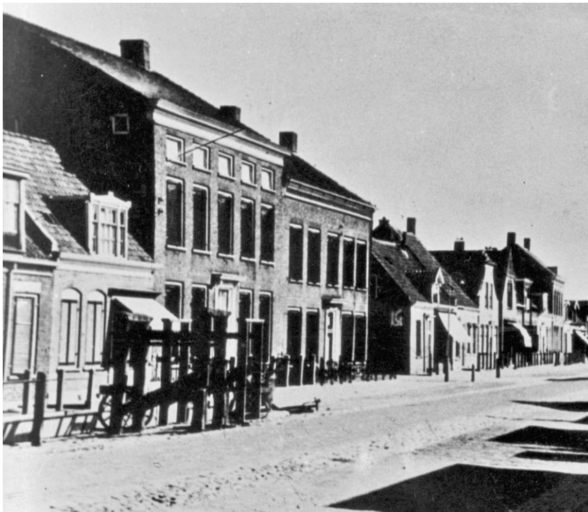
Fig. 3. Wissenkerke, Voorstraat, huidige nrs 13 en 15 (met 5 ramen op de 1 e verdieping van beide huizen). Links, schuin achter de hoofstal, ook travalje genoemd (stellage van de hoefsmid voor het beslaan van paarden), het huis van Abraham C. Vader (1806-1872), nr 13, waarschijnlijk ca. 1834 gebouwd, dat er anno 2014 nog steeds staat. Rechts op de hoek het huis, nr 15, van Maria A. Vader (1804-1887) en haar echtgenoot Hendrik J. Keijl (1793-1870), waarschijnlijk ca. 1828 gebouwd, in 1975 afgebroken.
